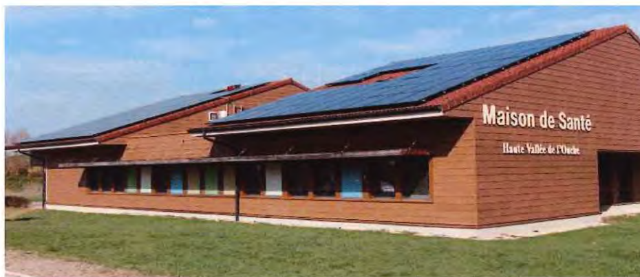
Centrale photovoltaïque en toiture sur la maison de santé à Bligny-sur-Ouche en service depuis 2020
