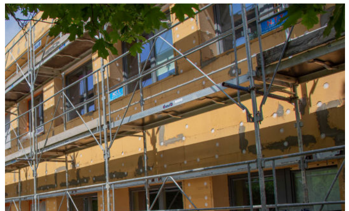
Exemple de travaux d'isolation extérieure ©SICECO TECO
